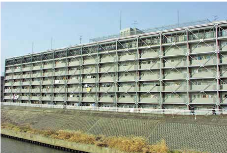
写真：パイプブレース型耐震補強工事
