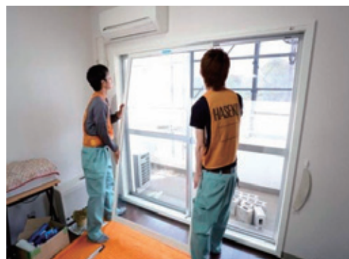
既存サッシの内側に樹脂サッシを新設
