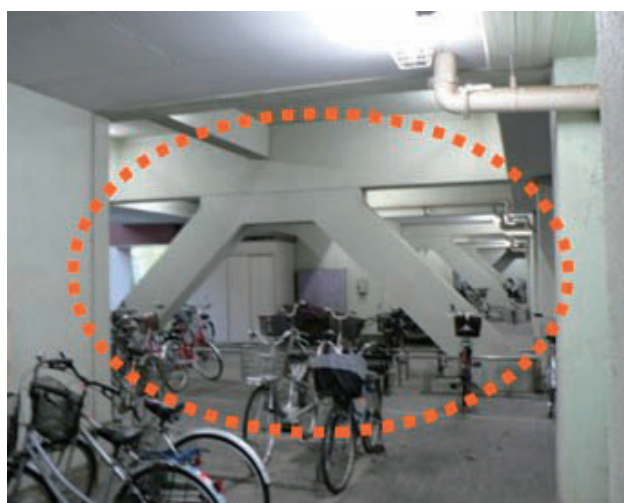
開口部の補強（鉄骨ブレース設置） （昭和 47(1972)年築）
