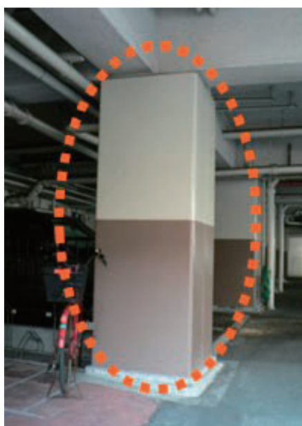
柱の補強（鋼管巻き補強） （昭和 45(1970)年築）
