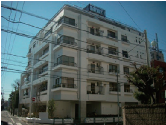
アウトフレーム工法による耐震補強
