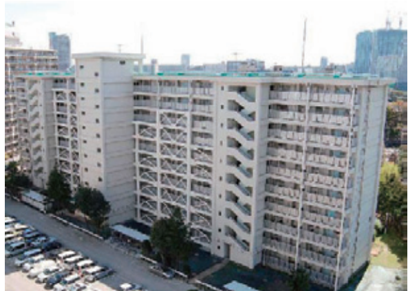
耐震改修されたマンション
