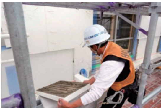
壁の外断熱工事
