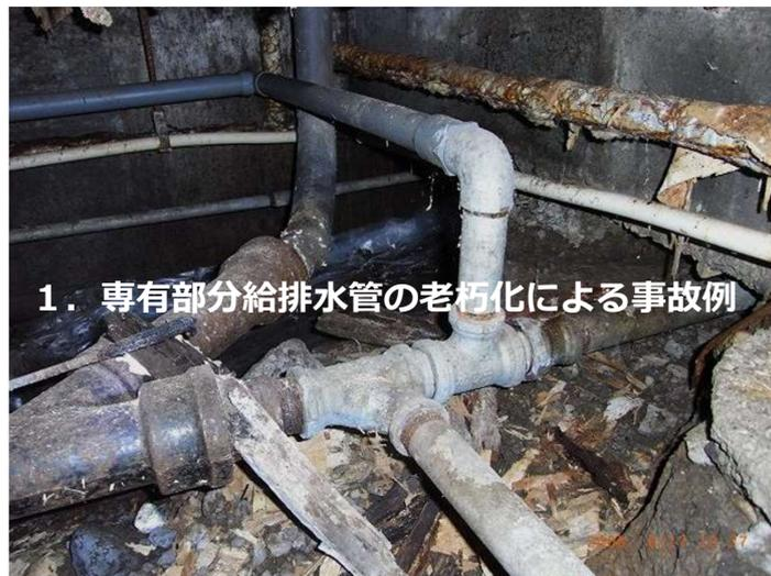
1. 専有部分給排水管の老朽化による事故例
