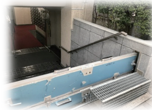
◀ エントランスの様子 （止水板設置後）
